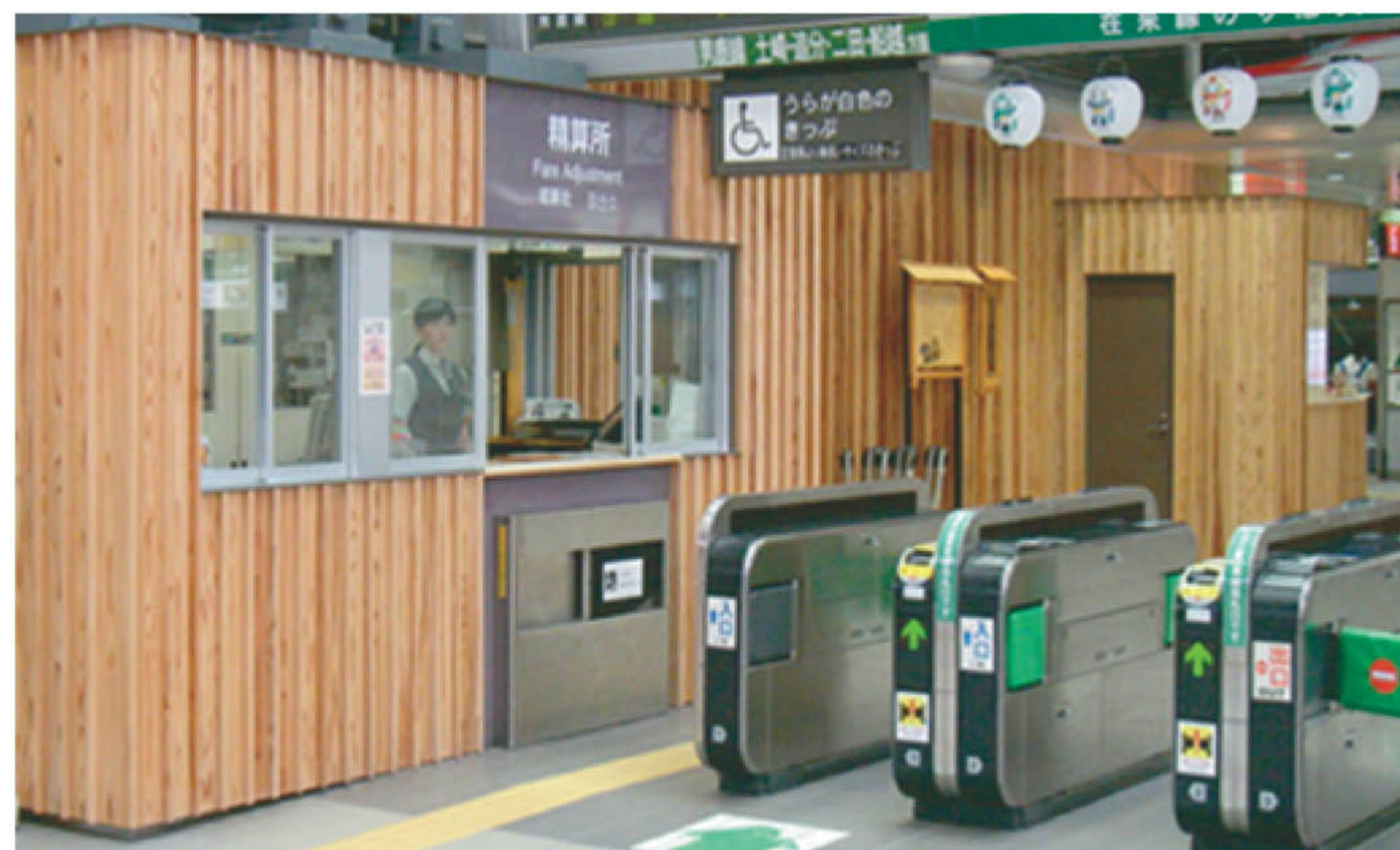
支給材(不燃加工) 駅構内
